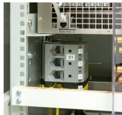
Входной АС терминал / AC input terminal
