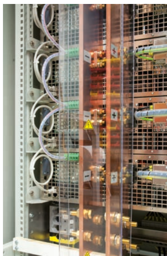
Шина DC терминала / DC bus terminal
